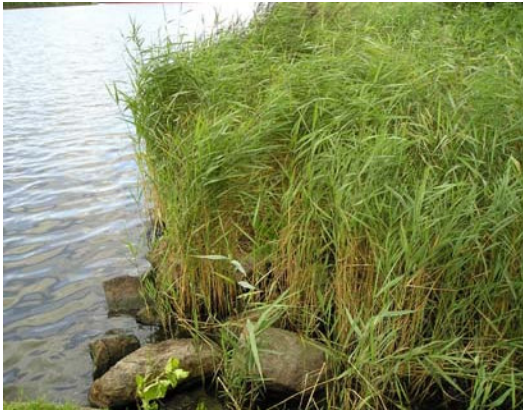
Oeverbegroeiing na aanleg van de steenstort oeververdediging.
