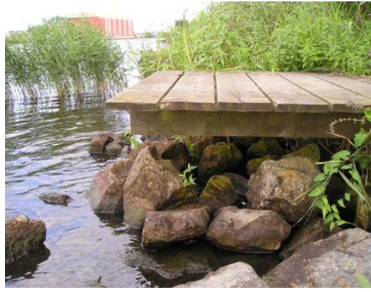
Zijaanzicht van de vissteigers geplaatst op perkoenpalen fundering
